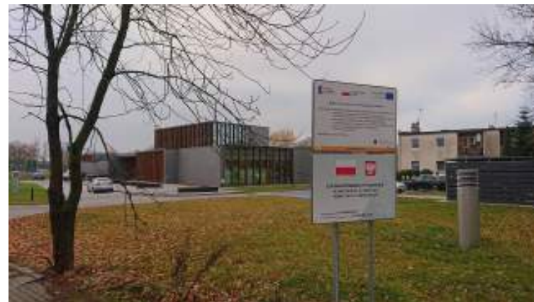
Budowa Przedszkola Miejskiego w Mroczy
