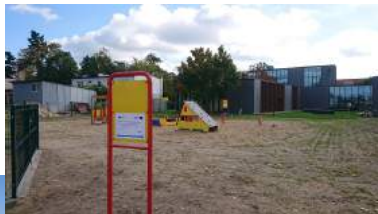
Budowa placu zabaw przy Przedszkolu Miejskim w Mroczy.
