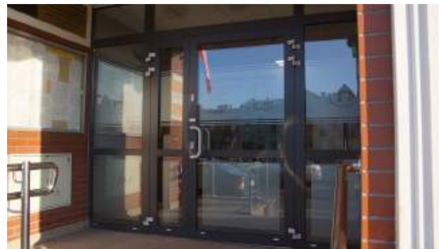
Drzwi wejściowe do budynku Urzędu Miasta i Gminy w Mroczy po przebudowie
