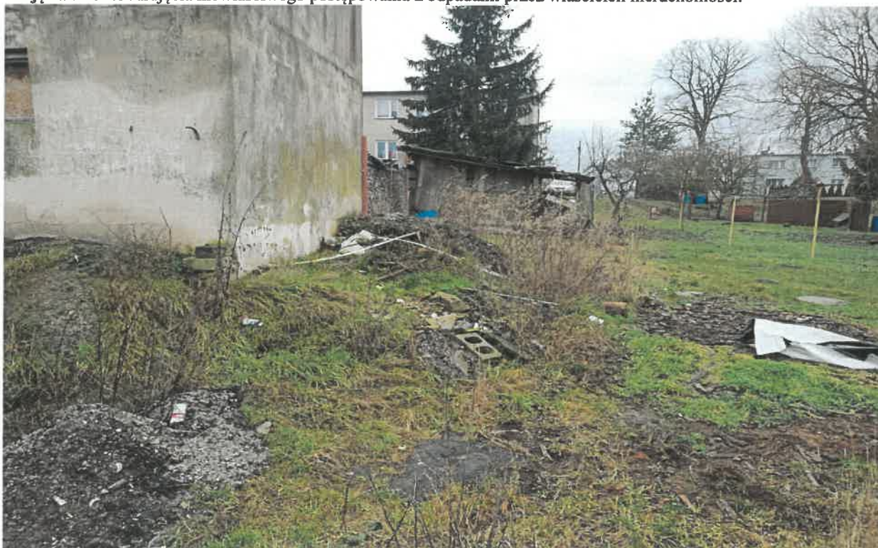
Zdjęcia nr 9-12. Zdjęcia niewłaściwego postępowania z odpadami przez właścicieli nieruchomości.
